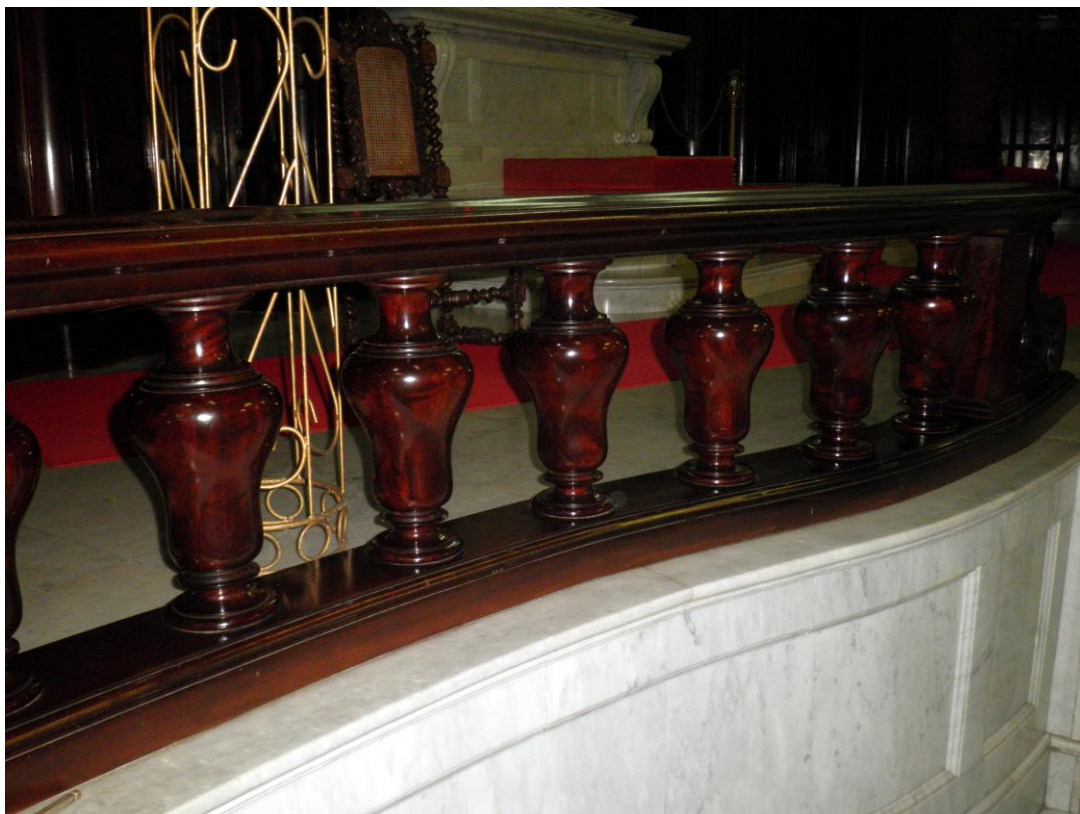
DETALHE DA BALAUSTRADA DE COLUNELOS DE JACARANDÁ NO ALTAR MOR (Foto P. Tosatto)
