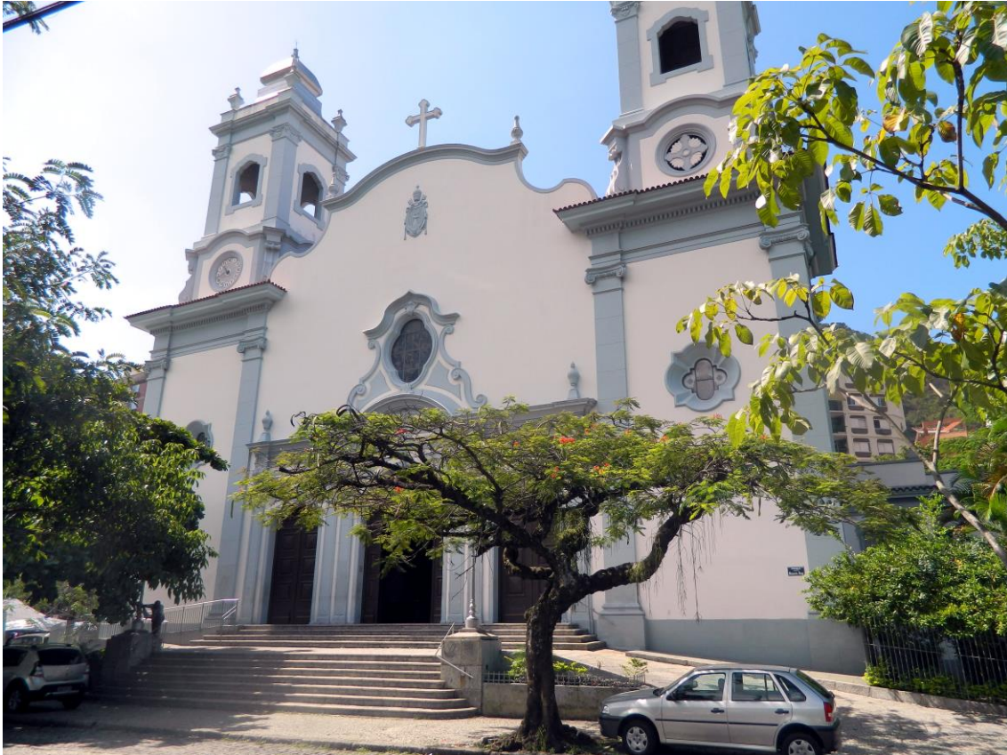
FACHADA PRINCIPAL DA IGREJA E SUA ESCADARIA. (Foto P. Tosatto)
