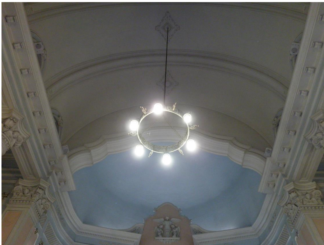
O CANDELABRO DA ABÓBADA CENTRAL MAIS PRÓXIMO AO PRESBITÉRIO (Foto P. Tosatto)
