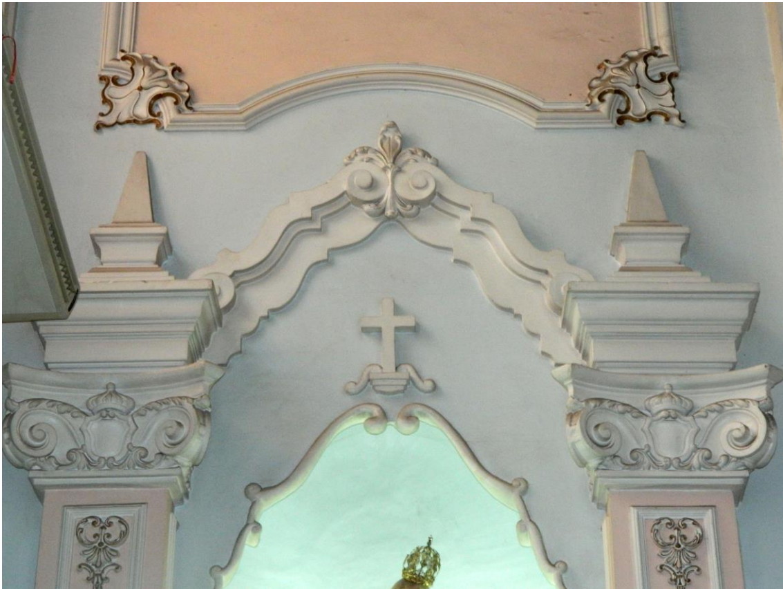
DETALHE DA MOLDURA SUPERIOR DO NICHU DA COLATERAL. (Foto P. Tosatto)
