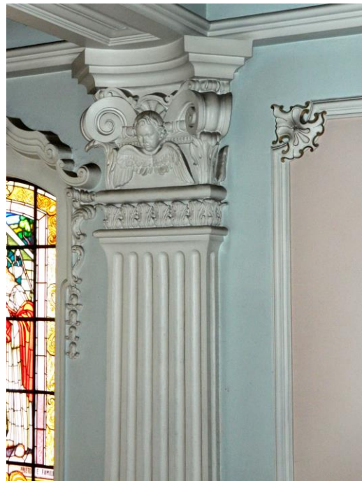
DETALHE DO CAPITEL DE UMA PILASTRA FUNDIDA NA PAREDE (Foto P. Tosatto)
