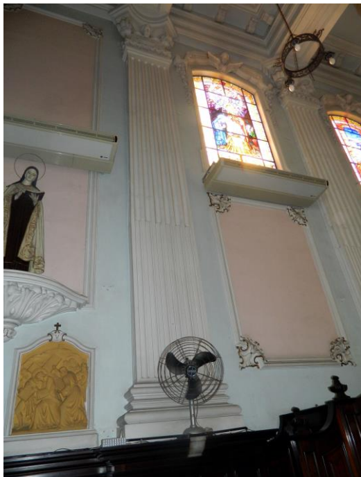
UMA PILASTRA FUNDIDA NA PAREDE (Foto P. Tosatto)
