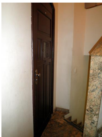
A PORTA DE ACESSO À RUA FONTE DA SAUDADE (Foto P. Tosatto)
