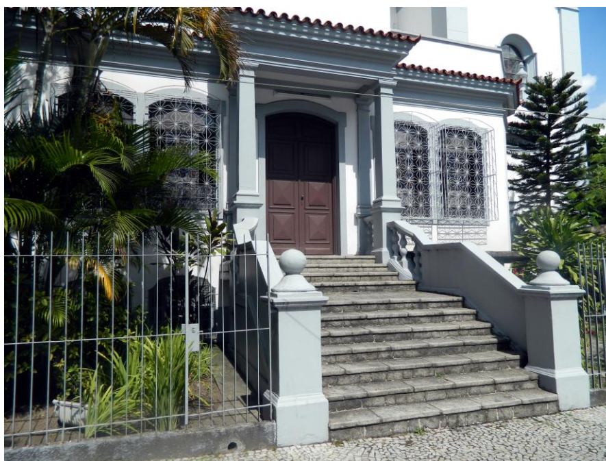
ESCADARIA DE ACESSO À SECRETARIA (Foto P. Tosatto)
