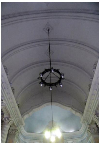
ARCOS EM RELEVO NA ABÓBADA DA IGREJA (Foto P. Tosatto)
