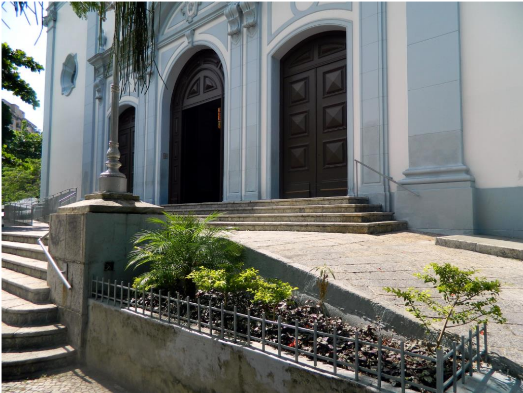
NESTA FOTO PODE-SE TER UMA VISÃO PARCIAL DO CONJUNTO DA FACHADA PRINCIPAL COM SUA ESCADARIA, RAMPA DE ACESSO, FUSTE DE UM CANDELABRO E OS TRÊS PORTAIS. (Foto P. Tosatto)
