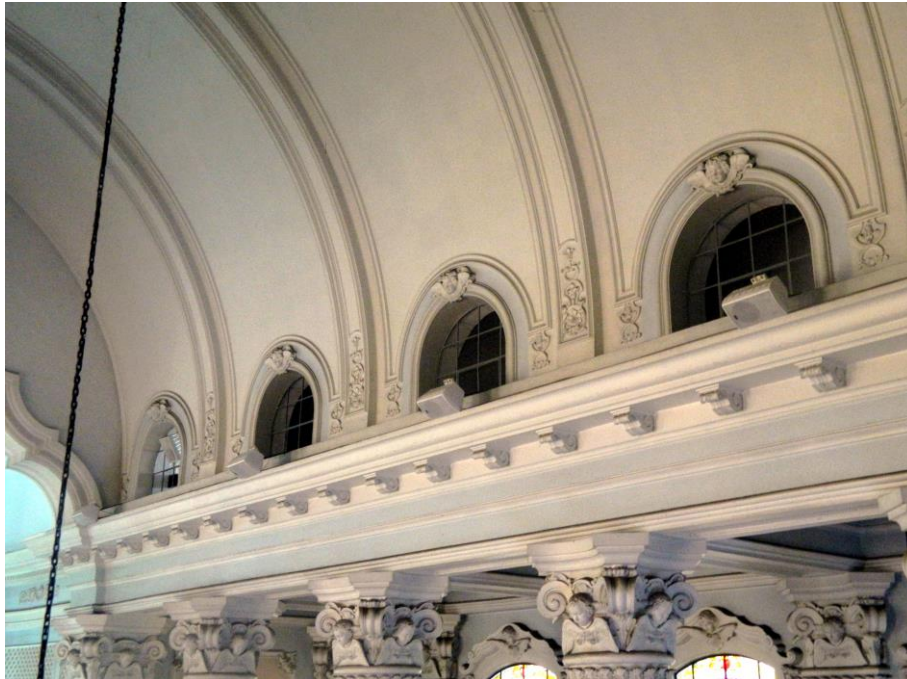
A ARQUITRAVE DO LADO DIREITO DA NAVE, COM AS JANELAS E OS ALTO FALANTES (Foto P. Tosatto)
